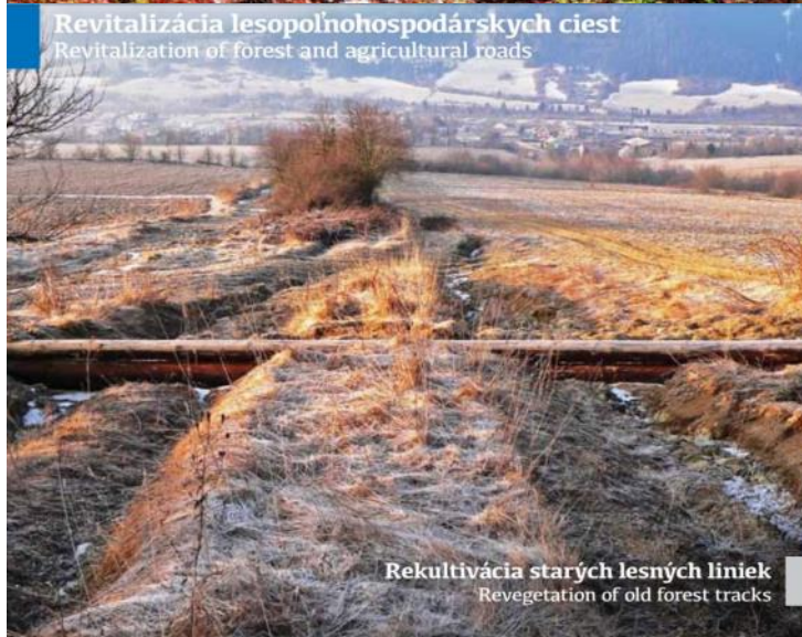
Prekladané hrádzky Interlaced check dams
