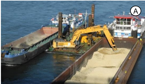
Sohlanpassung u. Granulometrische Sohlverbesserung – Erprobung der Einbaumethode – rd 130.000 m 3 Kies
