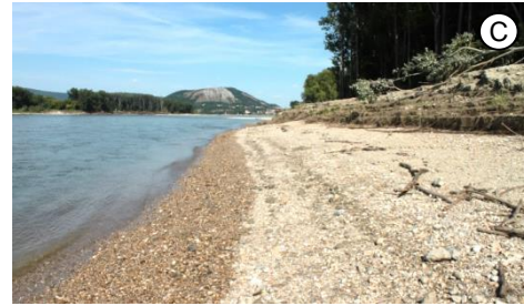
Uferrückbau 1,4 km Abtrag der Steinsicherungen
