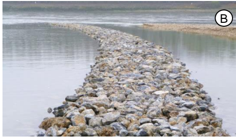
Buhnenoptimierung – Neubau bzw. Umbau (19 Abtrag, 10 Neubau) Absenkung an der Buhnenwurzel
