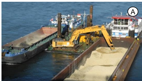
Úprava dna a granulometrické vylepšení dna – vyzkoušení metody zapravení – cca 130.000 m 3 štěrku
