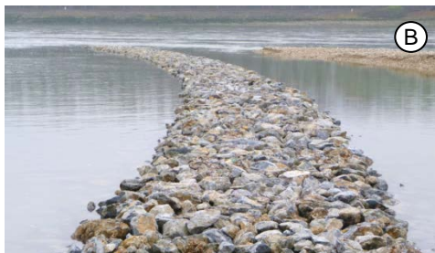
Optimalizace příčné hráze – novostavba resp. přestavba (19 sejmutí, 10 nová výstavba) Zanoření na hloubku čela hráze
