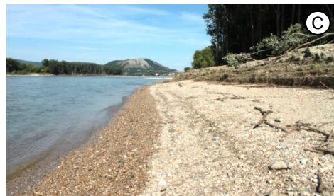
Rozebrání hráze v délce 1,4 km Odstranění kamenné opory
